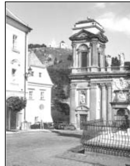
Ditrichštejnská hrobka / Dietrichsteiner Gruft
